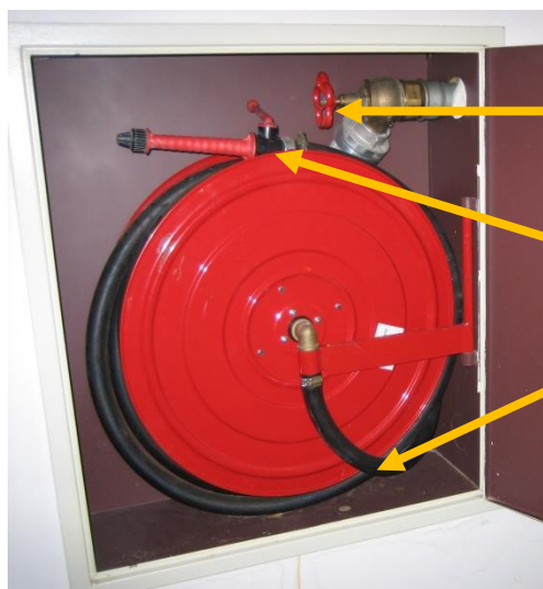
Abb.4.4.2: geöffneter Wandhydrantenkasten
